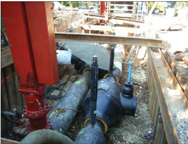
Bild 8. Stopple im Vorlauf während der Rohrbauarbeiten
