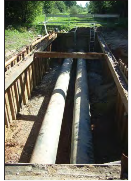
Bild 5. Baugrube mit freigelegter 450 KMR 630
